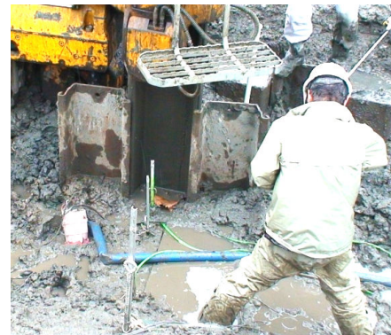
写真1 矢板の引抜き状況
