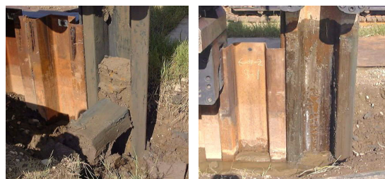
(a)無処理鋼矢板 (土の付着) (b)摩擦低減剤を塗布した鋼矢板 (土の付着) 写真-1 鋼矢板の引抜き
