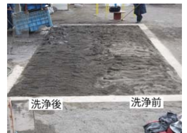
(d) 洗浄前後の状況
