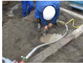
(c) エジェクターによる加水吸引の状況
